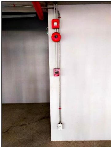
ระบบตรวจสอบและแจ้งเหตุเพลิงไหม้
