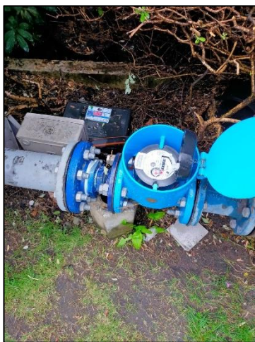
มิเตอร์รับน้ำจากการประปานครหลวง สาขาพญาไท
